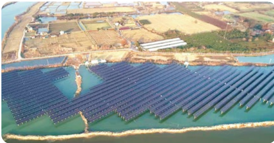
新能公司安徽芜湖方村 1.19 万千瓦光伏项目
