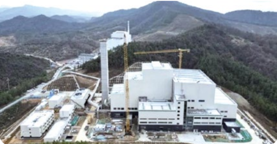
皖能环保公司池州市生活垃圾焚烧发电二期项目
