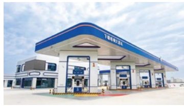
皖能下塘综合能源港（梧桐大道站）
