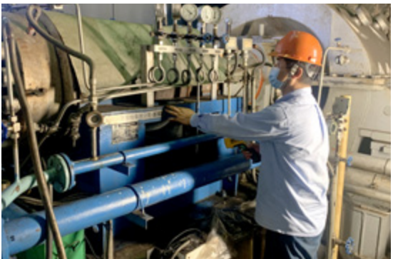
皖能运检公司印尼芝拉扎项目部职工测量设备温度
